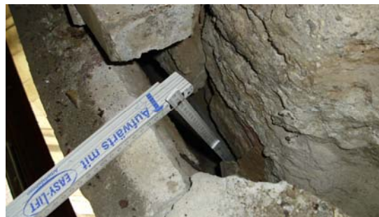
Kammerwandverformung
