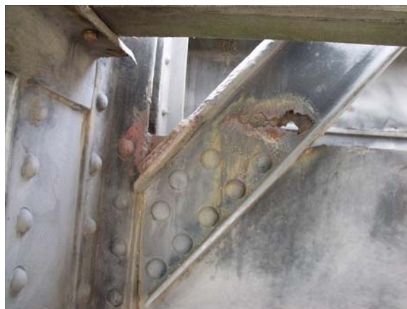
Hafendrehbrücke – Korrosionsschäden
