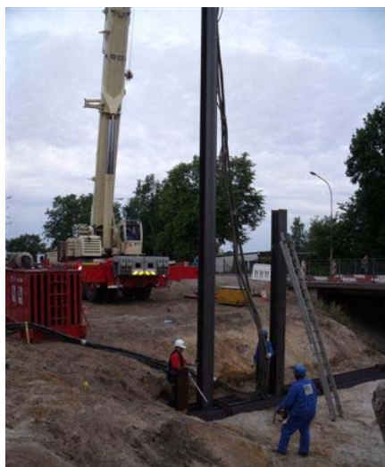
Einbringen Verbauträger am Widerlager West (29.08.2012)
