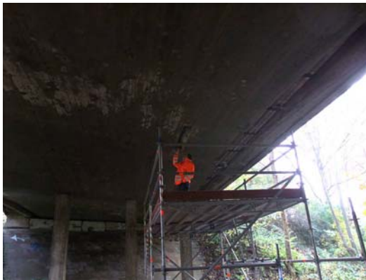
Entnahmestelle 1 der Spannstähle
