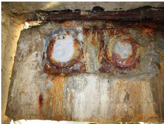
Freiliegende Spannköpfe
