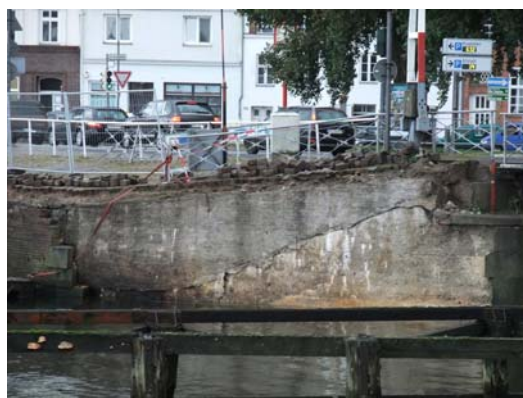
Ansicht Ufermauer nach Abriss Vorsatzschale
