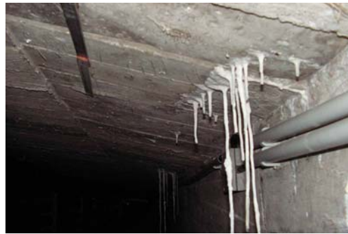
Aussinterungen im Hohlkasten Ost
