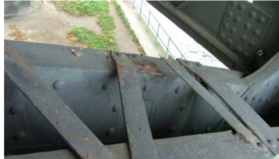
Laschen der Längsträger abgerissen
