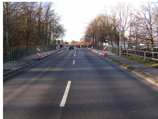
Draufsicht Straßenbrücke Wesloe
