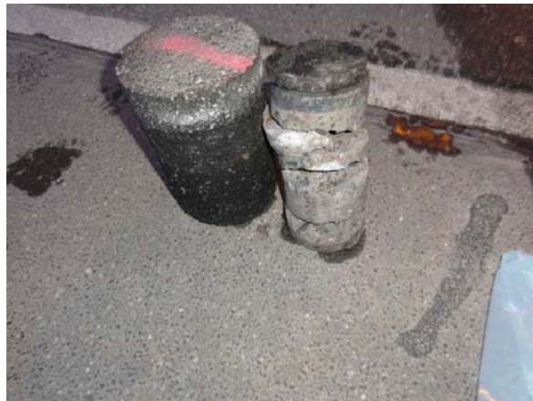
Possehlbrücke - AKR-geschädigter Beton
