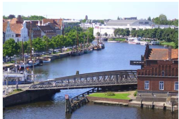
Luftbild der Hafendrehbrücke
