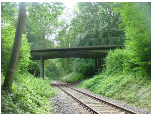
Seitenansicht Straßenbrücke Wesloe
