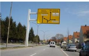
Verkehrszeichenbrücken sind Tragkonstruktionen, an denen Schilder/Zeichengeber über dem Verkehrsraum befestigt werden. Zu den Verkehrszeichenbrücken zählen auch entsprechende Tragkonstruktionen mit einseitiger oder beidseitiger Auskragung sowie Konstruktionen, die portalartig ganz oder teilweise über die Fahrbahn reichen.
