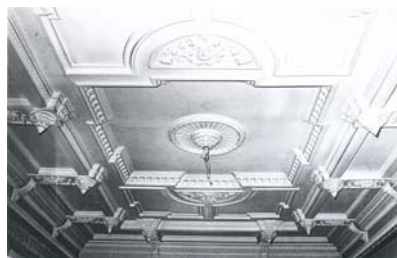
Decke im Saal
