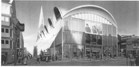
Zur Holstenstraße rückt der Neubau bis an die Bauflucht des Marktsüdriegels vor. Fotos: Udo Meinel. Bauwelt 2005/14.26 (8.4.2005)
