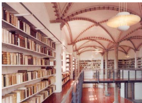
Erster zu Bibliothekszwecken neu erbauter Saal, um 1877 unter Bibliotheksdirektor Wilhelm Mantels eingerichtet, bis 1926 Lesesaal. 1993-1995 saniert (Architekt Klaus Mai). Die moderne Stahlgalerie fängt den Druck der flachen neugotischen Gewölbe auf das dünnwandige Gebäude ab. © Bibliothek der Hansestadt Lübeck
