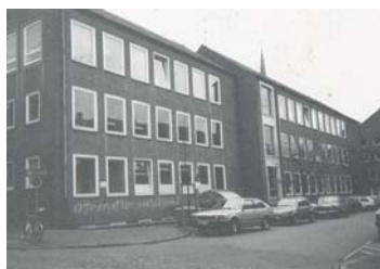
1. Bauabschnitt: Westansicht Gerade Querstr.
