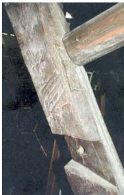
Sparren mit Abbundzeichen (5 Striche für 5. Gebinde) und leere Blattsasse
