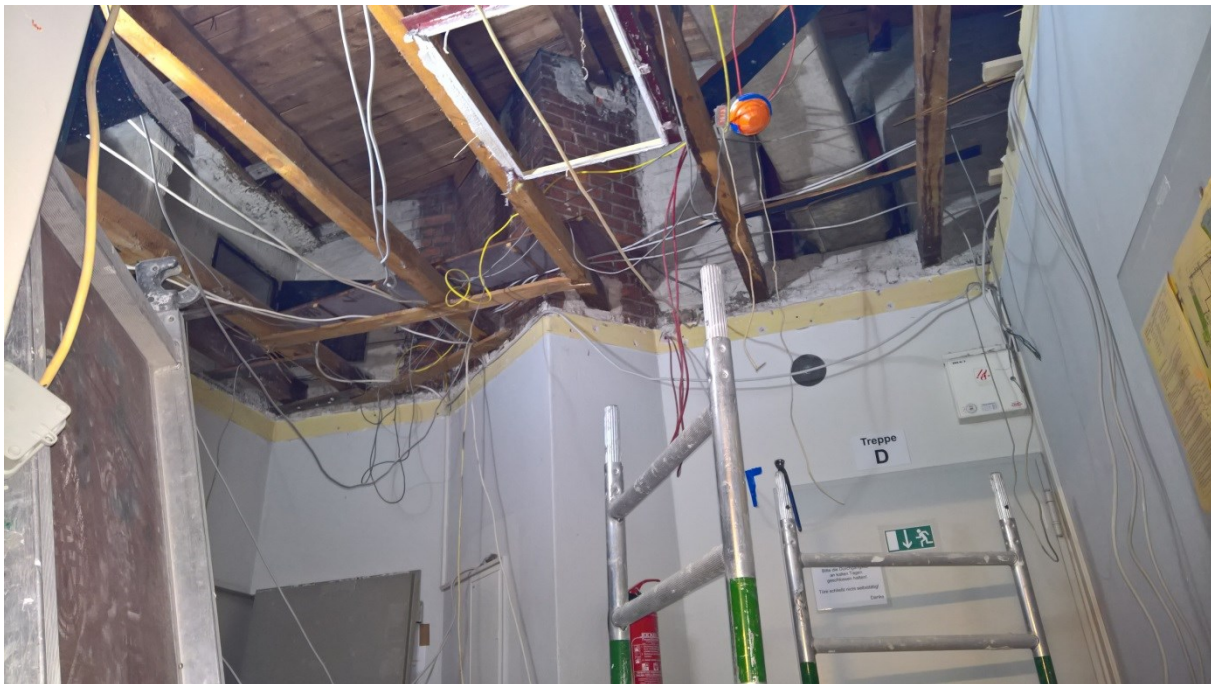
Arbeiten zur Aktualisierung des Brandschutzes: Abriss von Decken, Neuverkabelung, Einzug neuer Decken, Türen usw.
