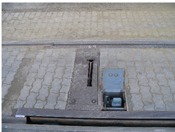
Bild 3 Weiche 104 (Stahlkasten offen)
