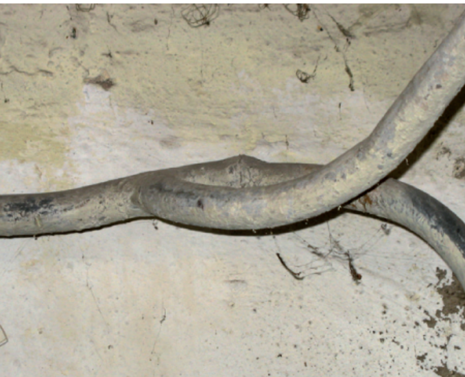
Typische Bleirohr-Installation
