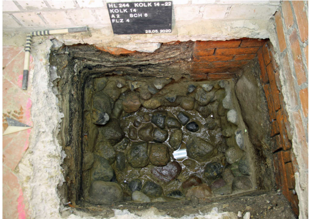
Abb. 12 Obere Schicht des massiven, mehrere Meter starken Findlingsfundamentes eines Steinwerks. Nach Westen Laibung eines ehemaligen zur Trave führenden Tores, dazu im Profil als dunkle Bänder die Lehmfußböden, spätes 12. Jahrhundert.
