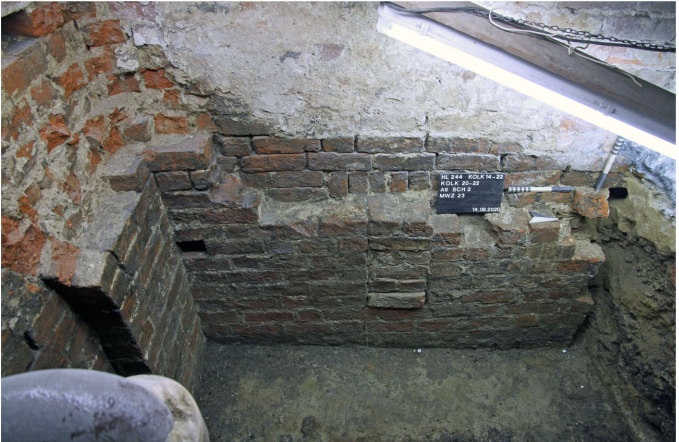
Abb. 20 Westmauer des Hauses mit zugemauerter Nische und in der Ecke das Balkenloch für die Türverriegelung der nach Süden anschließenden Türöffnung.
