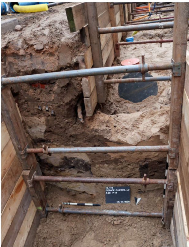
Abb. 42 Der Wechsel aus Planier- und Abbruchschichten dokumentiert insgesamt fünf Straßenniveaus. Mittig gestört durch den Leitungsgraben der Mischwasserleitung.
