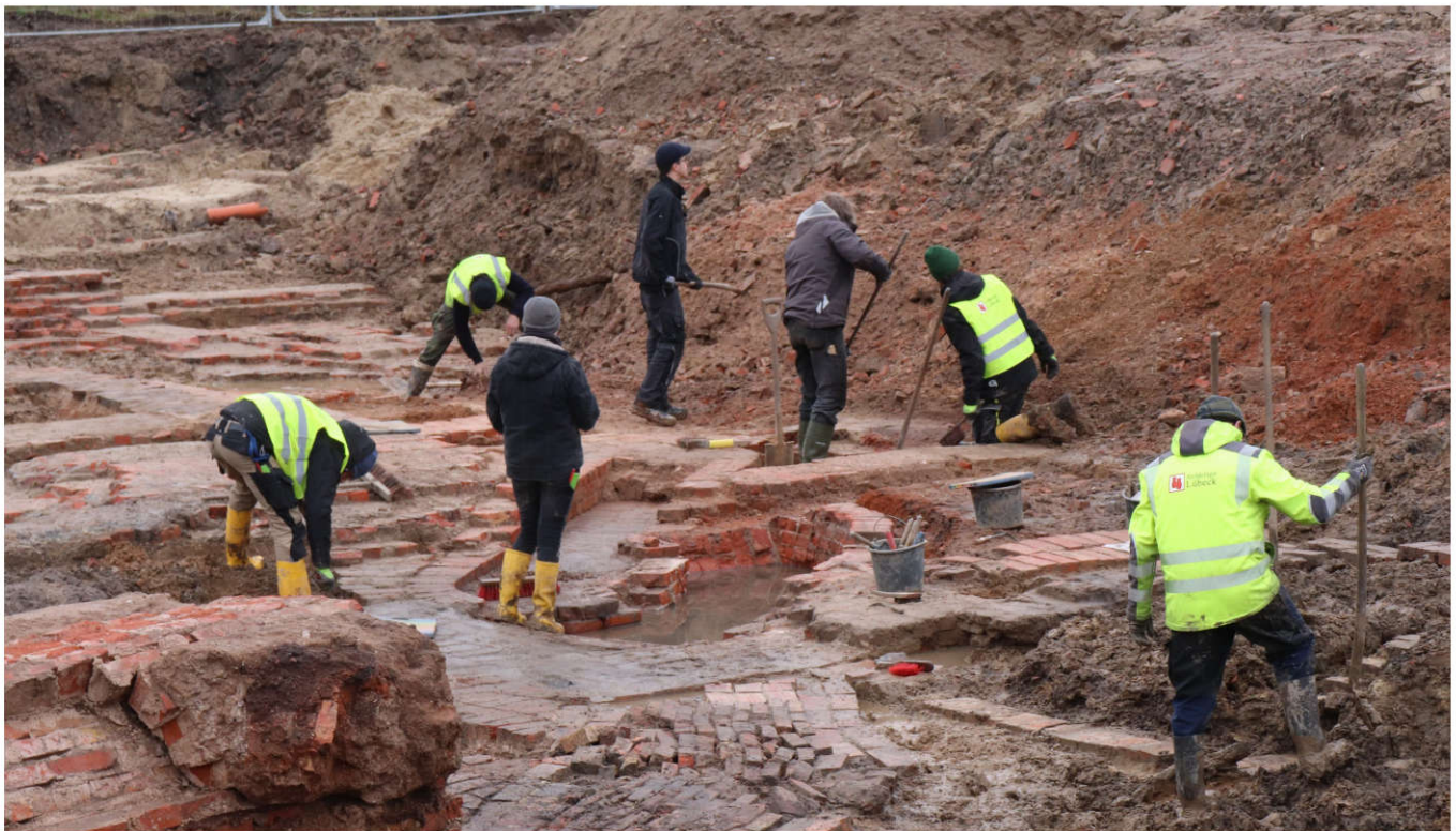
Abb. 28 Teilnehmer der Jugendbauhütte Lübeck und Grabungsfacharbeiter beim Freilegen der baulichen Reste der Dampf-Kornbrennerei.
