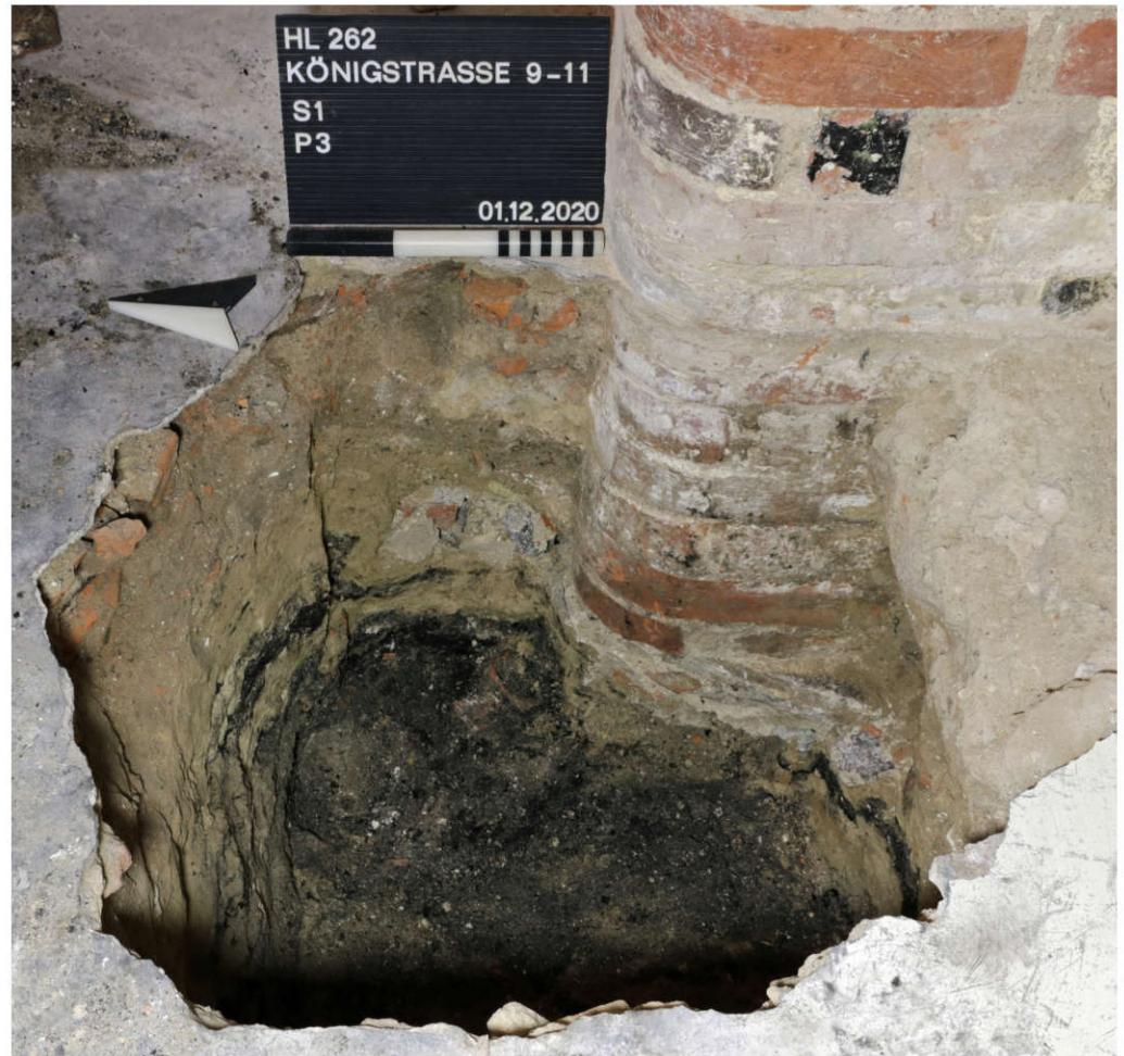
Abb. 8 Pfeiler mit Viertelstab-Formsteinen im hinteren Balkenkeller.
