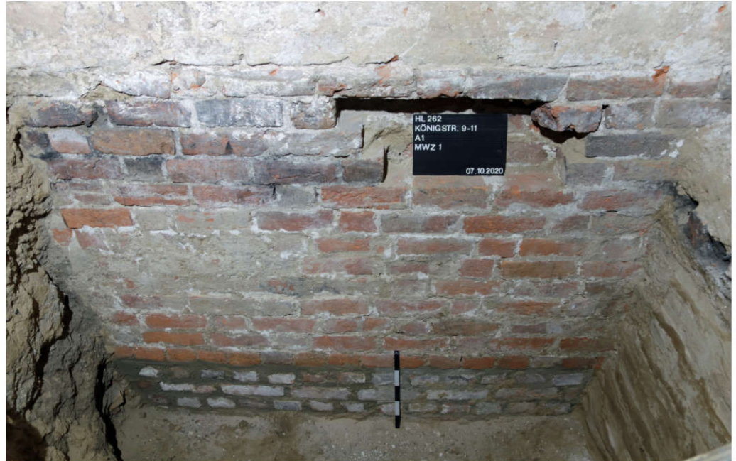
Abb. 6 Unterfangene Kellermauer zwischen Königstraße 9 und 11 aus dem späten 13. Jahrhundert.
