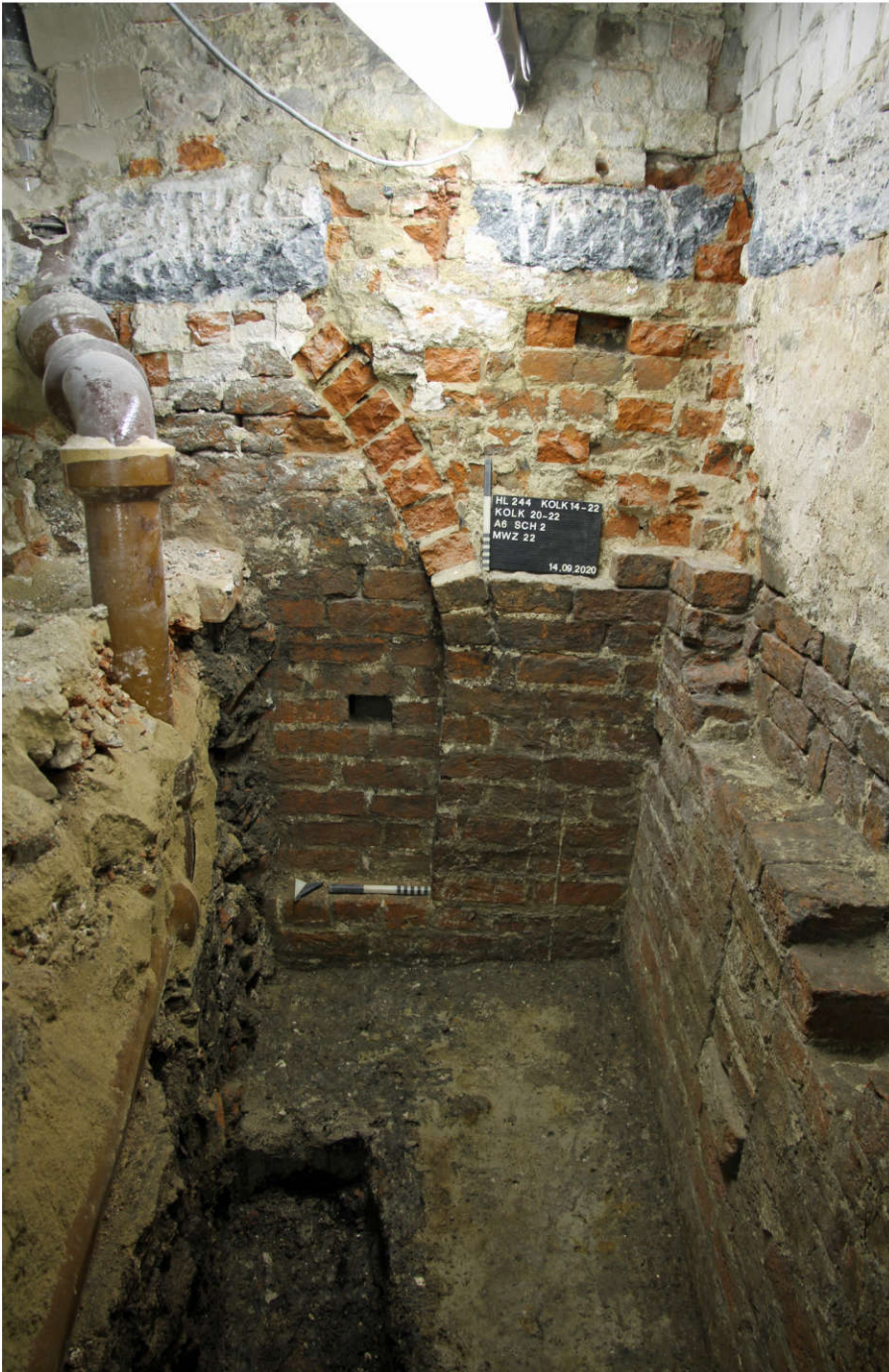
Abb. 19 Zugemauerte Süd-West-Ecke des großen spätmittelalterlichen Backsteinhauses.
