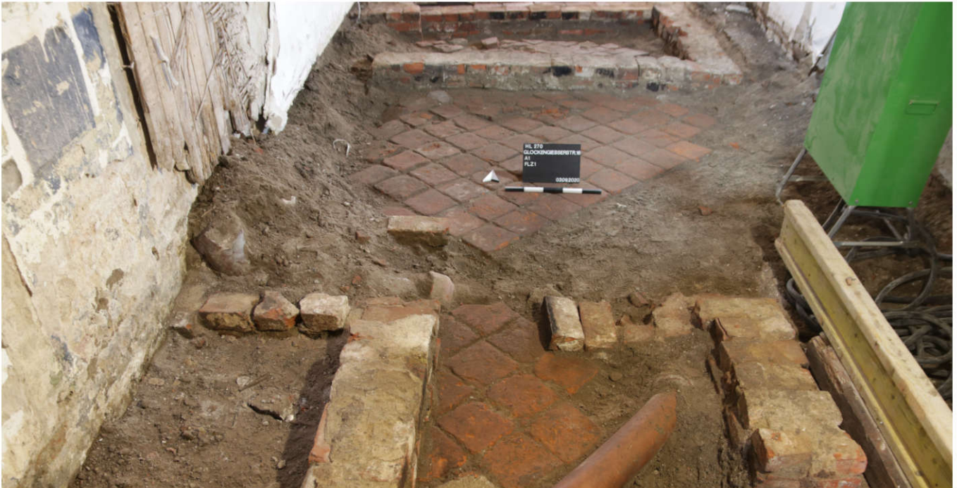
Abb. 34 Trennmauern, Steinsockel und Backsteinfußböden zeugen von dem immerwährenden Umbau des Hausinneren.
