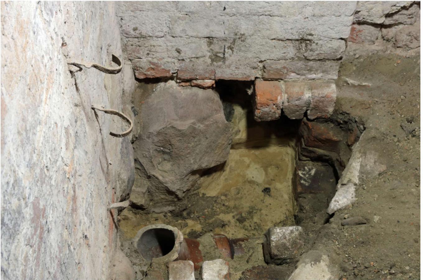
Abb. 9 Südwestecke des Steinwerks des frühen 13. Jahrhunderts mit Fundamentierung und Rollschicht.
