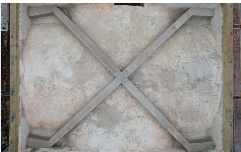
Abb. 18 Das Gewölbe ist von oben gesichert.
