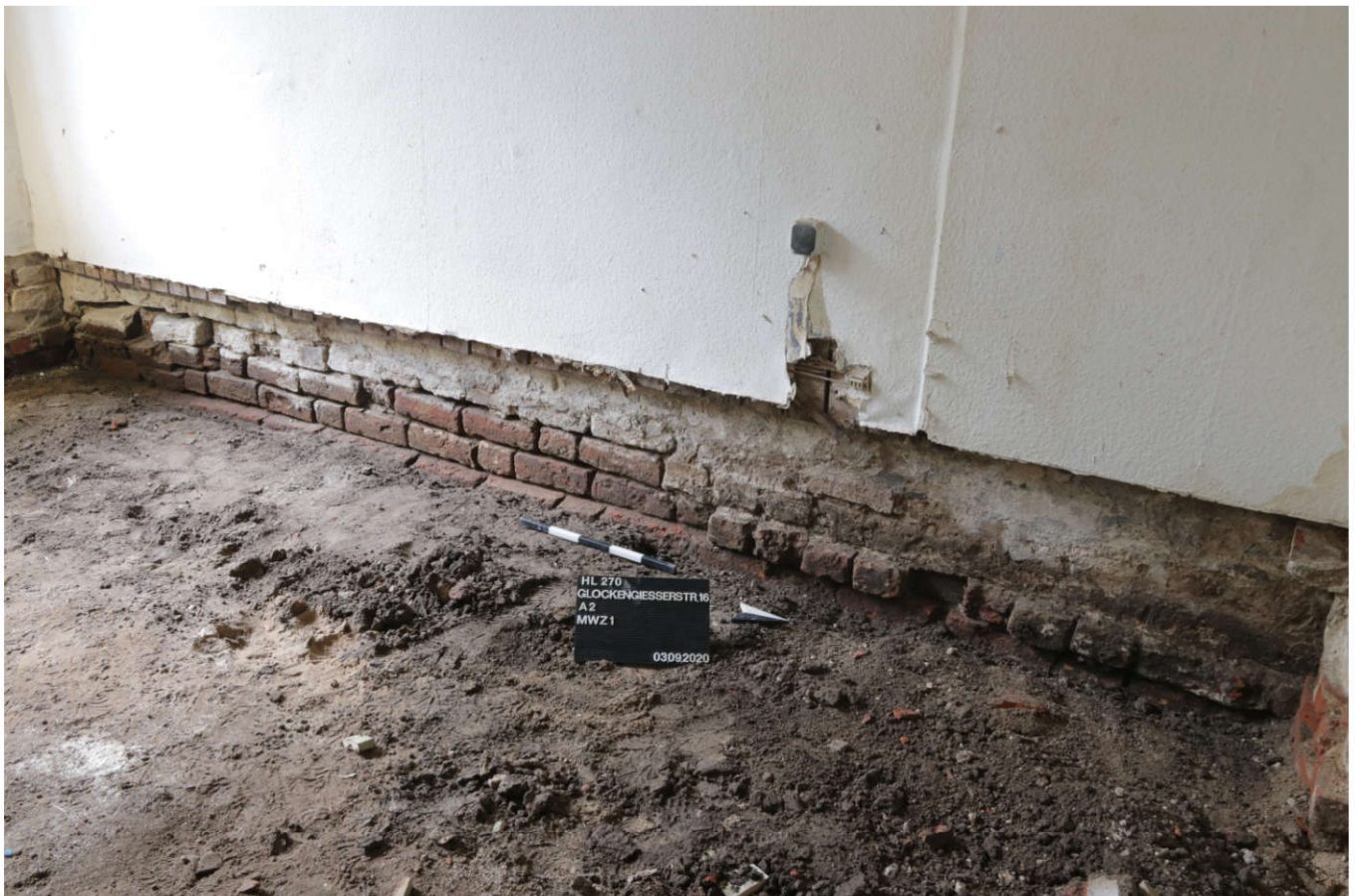
Abb. 33 Die westliche Brandmauer in den unteren Lagen datiert noch in die Erbauungszeit des bestehenden Gebäudes aus dem 14. Jahrhundert.
