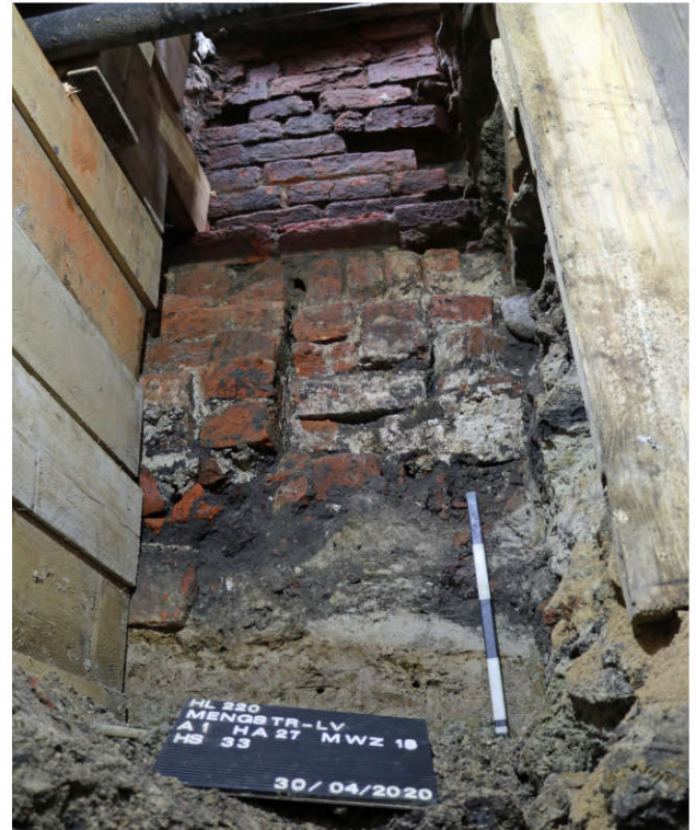
Abb. 47 Gründung des Vordergiebels der Mengstraße 33 mit Spuren diverser Umbauten.
