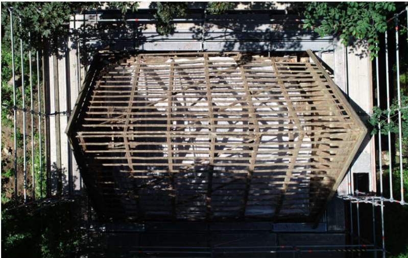
Abb. 16 Nach Abnehmen und Sichern der Dachdeckung erfolgte die Dokumentation des Dachstuhls mit der Drohne.
