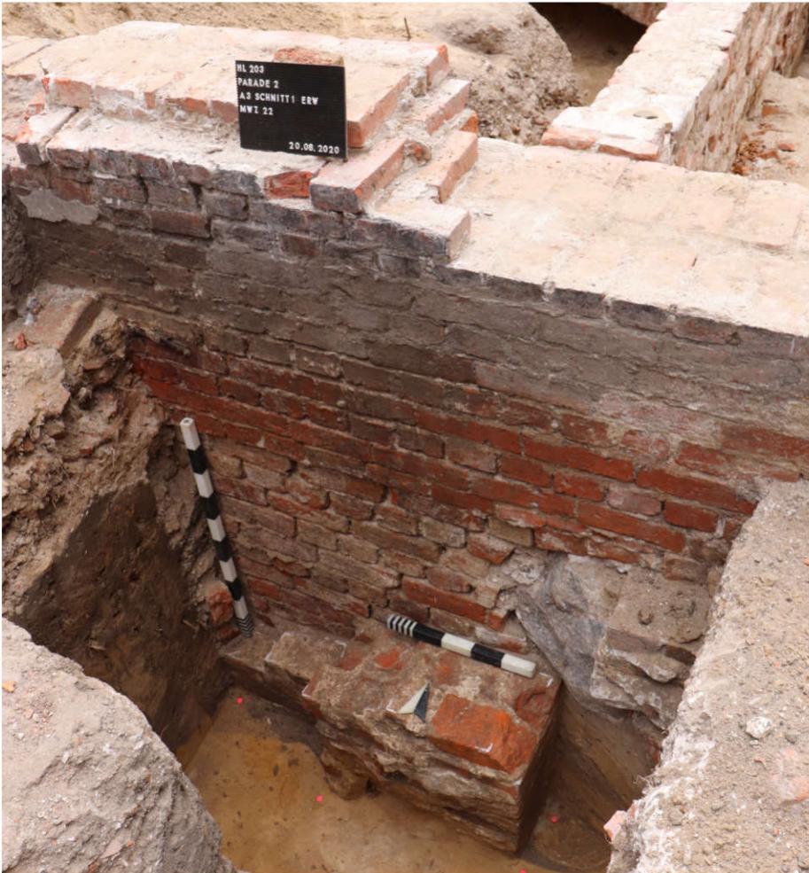
Abb. 30 Direkt auf den Resten der mittelalterlichen Kurie wurden die Fundamente der Reimannschen Villa gesetzt.
