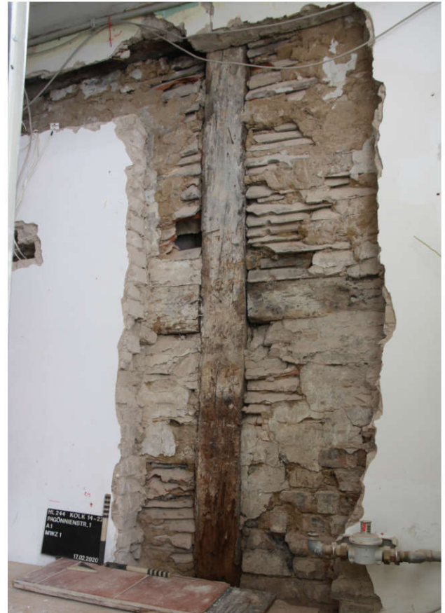
Abb. 17 Fachwerkwand aus der Mitte des 16. Jahrhunderts, ausgefacht mit aufeinandergestapelten Dachziegeln.
