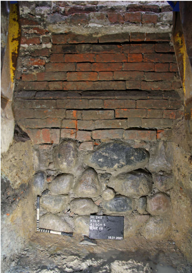
Abb. 16 Außenaufnahme des oberen Teil des Findlingsfundamentes und des ehemals aufgehenden Mauerwerks des Steinwerks mit schräg geschnittenem und geriefeltem Sockel, spätes 12. Jahrhundert.
