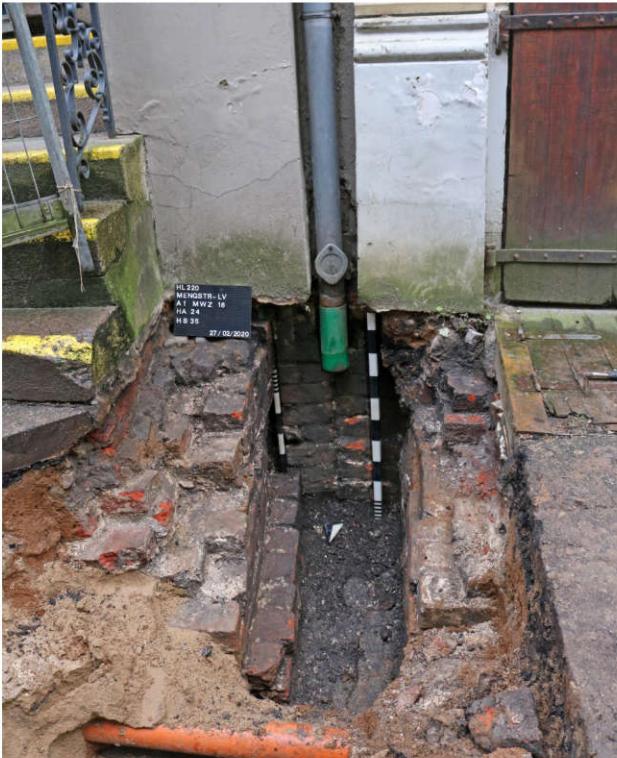
Abb. 46 Vertikale Baufuge zwischen den Vordergiebeln der Häuser Mengstraße 35 und 37. Links: die westliche Treppenwanne eines ehemaligen Kellerabgangs der Nr. 35 ist durch die heutige Eingangstreppe ins Erdgeschoss überbaut.
