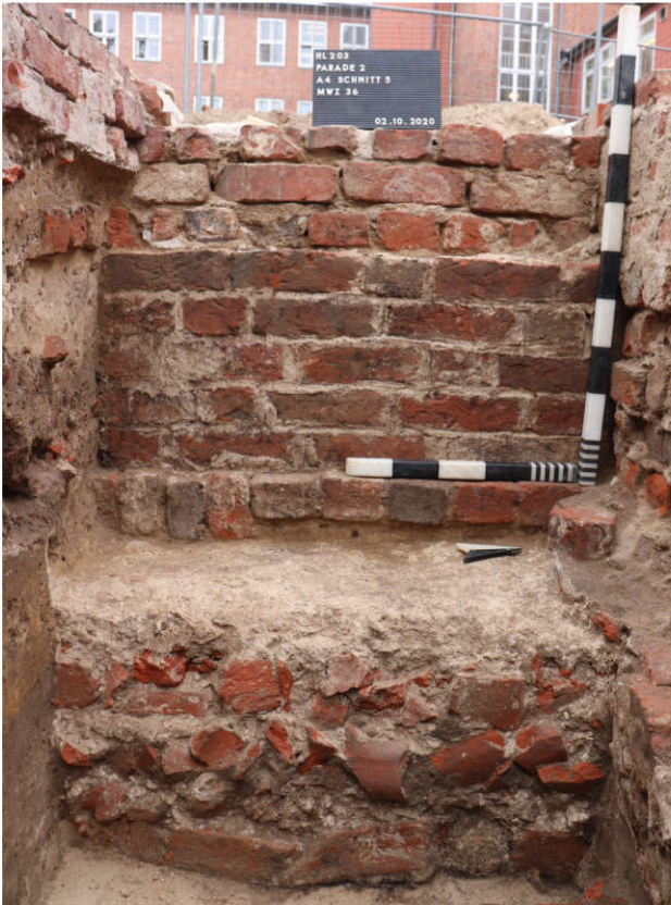
Abb. 26 Unterhalb des Mauerwerks der Kurie fanden sich massive Stäckungsschichten als Fundamentierung.
