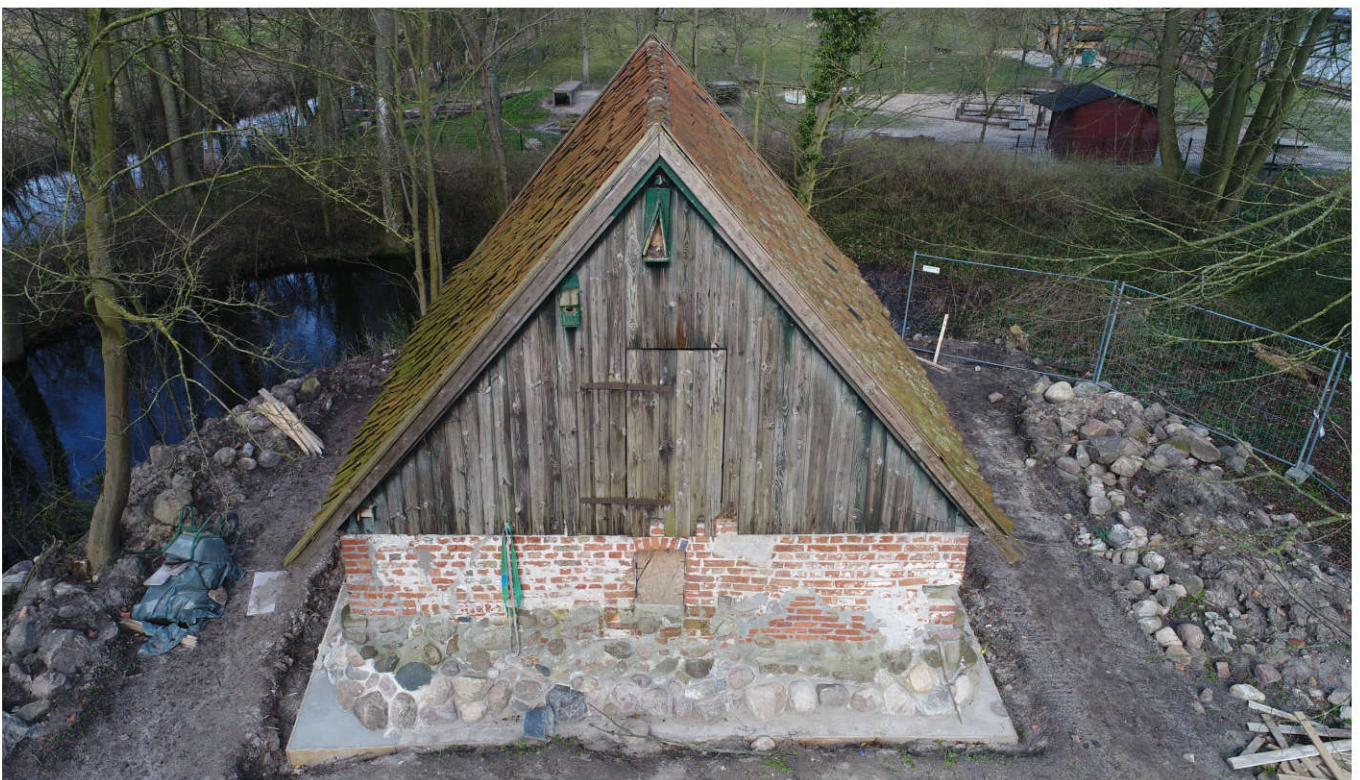
Abb. 15 Als erster Sanierungsschritt erfolgte die Sicherung des Feldsteinfundaments durch einen stahlbewehrten Betonanker.
