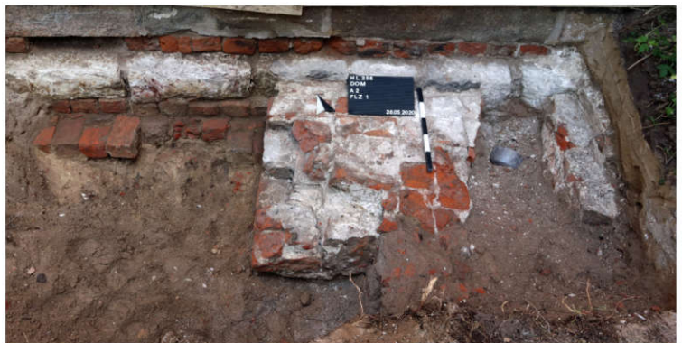
Abb. 59 Fundamentierung des südlichen Domturmes in originaler Lage sowie Anschluss der Klausur.
