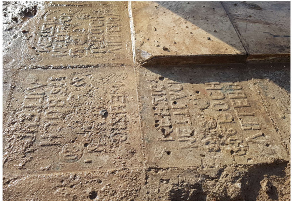
Abb. 40 Detailaufnahme eines Fliesenfußbodens der Kornbrennerei mit Firmenaufdruck „Villeroy & Boch, Mettlach / Merzig“.
