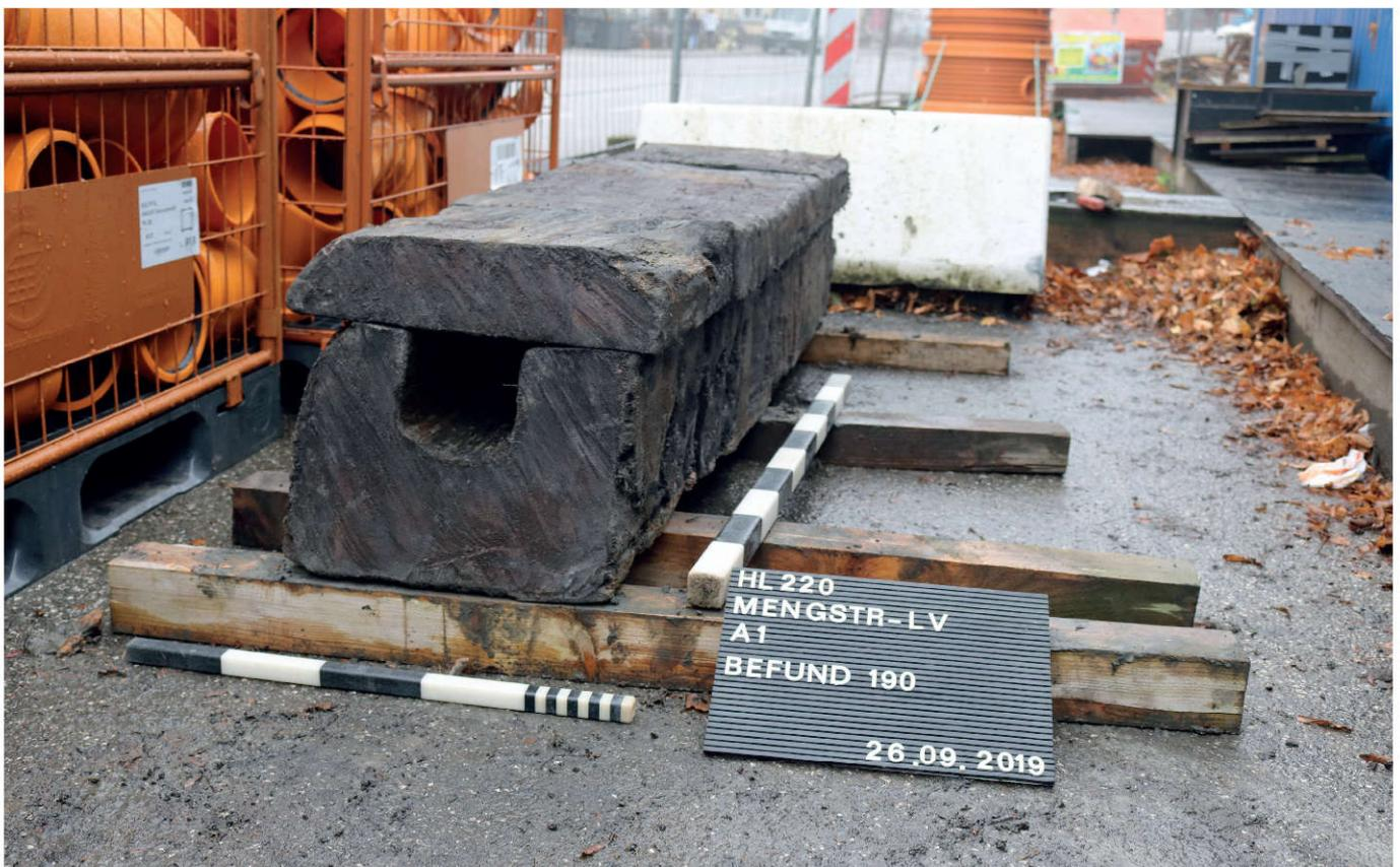
Abb. 37 Geborgener Teil der Holzleitung mit Laufrinne und Abdeckung, im Hintergrund die modernen neuen Leitungen.
