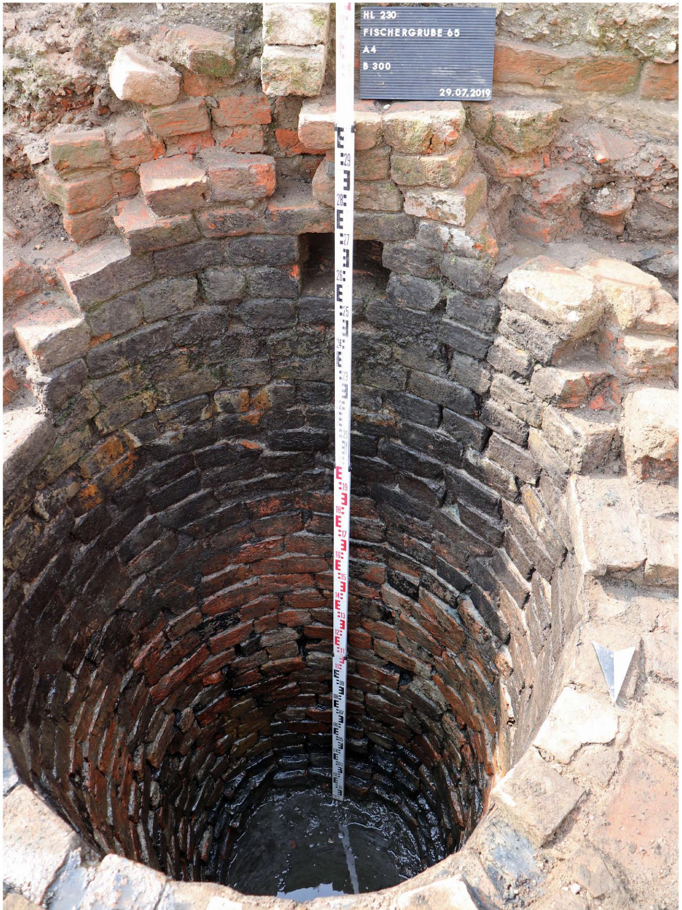
Abb. 10 Der Backsteinschacht im Hof von Fischergrube 65/67 diente ursprünglich als Zisterne, bevor er als Kloake benutzt wurde.
