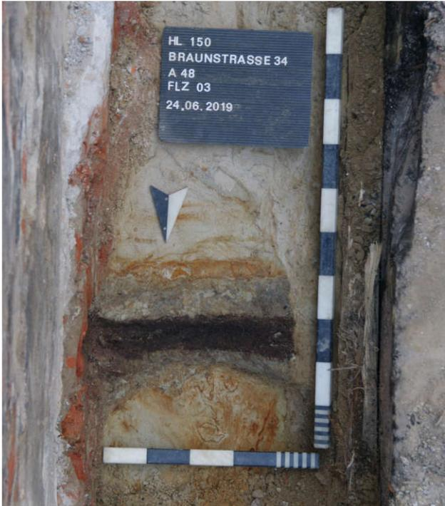
Abb. 18 Stark vergangene Reste eines Schwellbalkens des Holzkellers aus dem 12. Jahrhundert.
