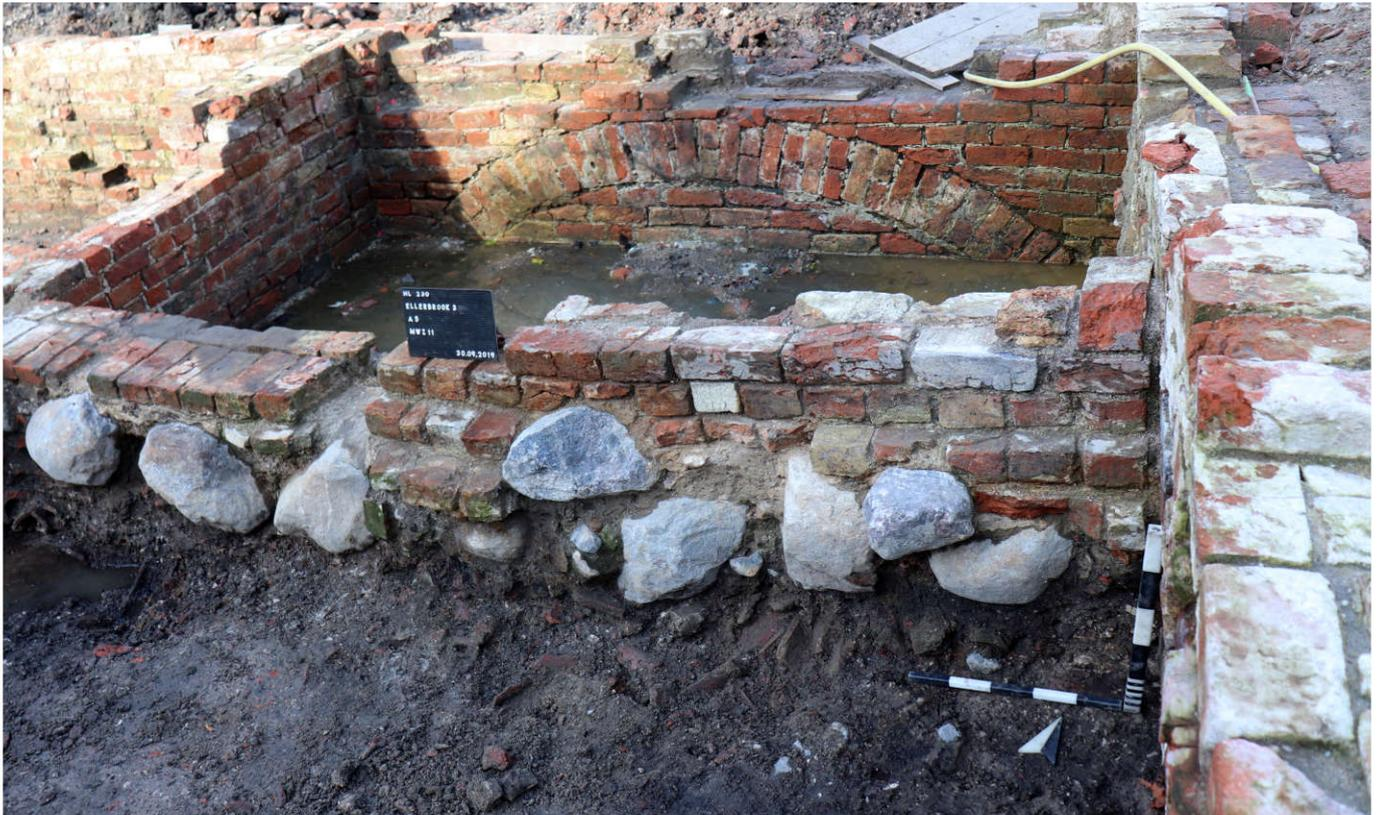
Abb. 11 Auf mächtigen Findlingen gründete die südliche Außenwand des Seitenflügels von Ellerbrook 3, im Norden stand sie oberhalb eines Entlastungsbogens auf.
