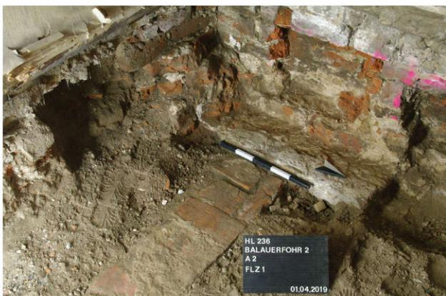
Abb. 46 Mittelalterliche Traufmauer aus Klosterformatsteinen.
