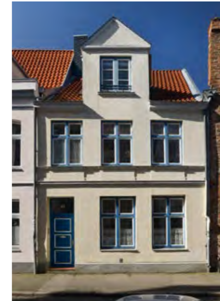
07.90 bis 07.94 Nach der Sanierung
