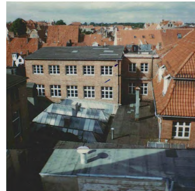
07.136 Hofsituation vor der Ordnungsmaßnahme
