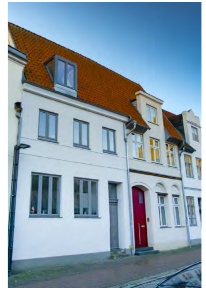
07.177 Straßenansicht nach der Sanierung
