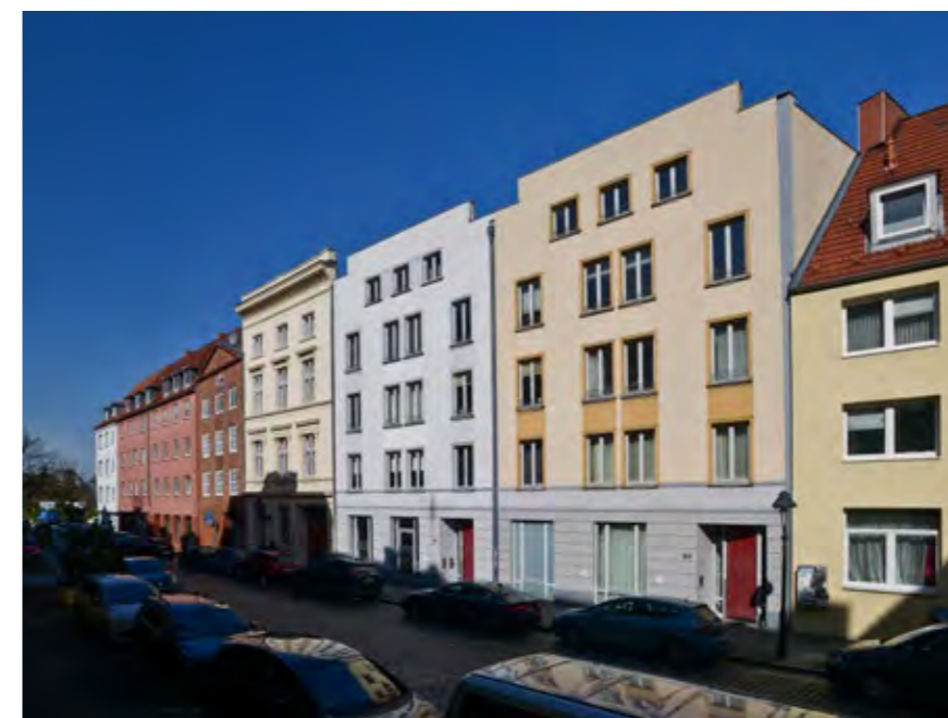
07.284 Sanierter Altbau (84) und Neubau Mehrfamilienhäuser(82 +80)
