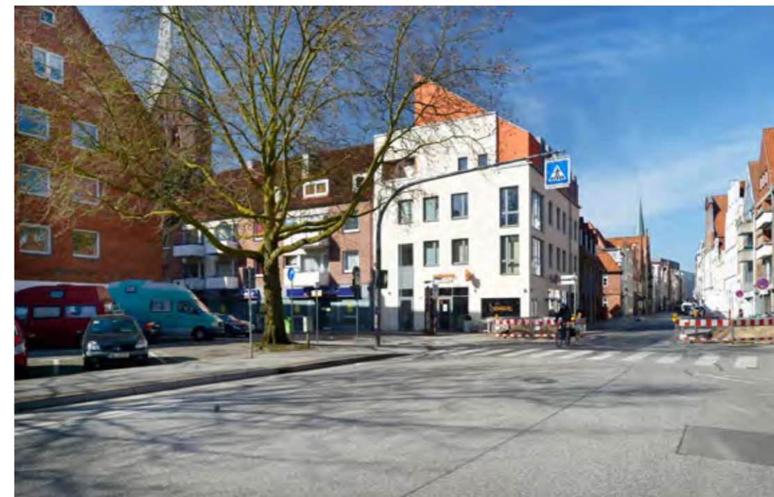
07.180 Neubau Wohn- und Geschäftshaus
