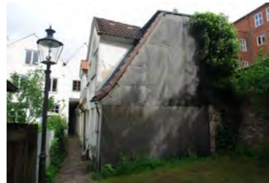
07.190 Brandwand Haus Nr. 2
