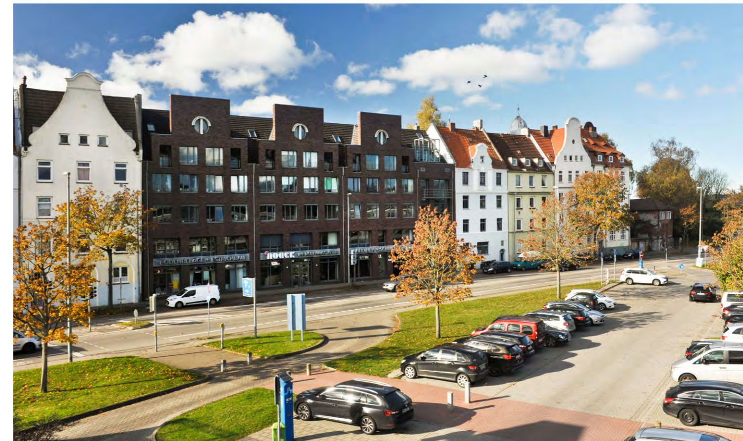
07.43 Neubau Wohn- und Geschäftshaus
