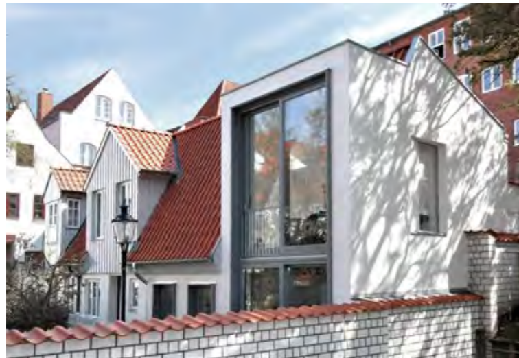
07.191 Neubau Haus Nr. 3
