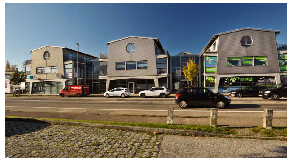
07.65 Kanalstraße 62-64, Neubau Gewerbehof
