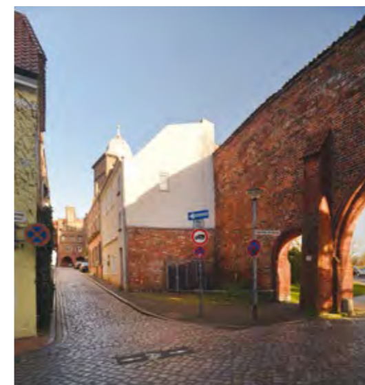
07.9 Kaiserstraße 3+5 nach der Sanierung
