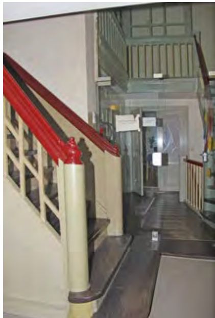
07.326 Treppe im OG
