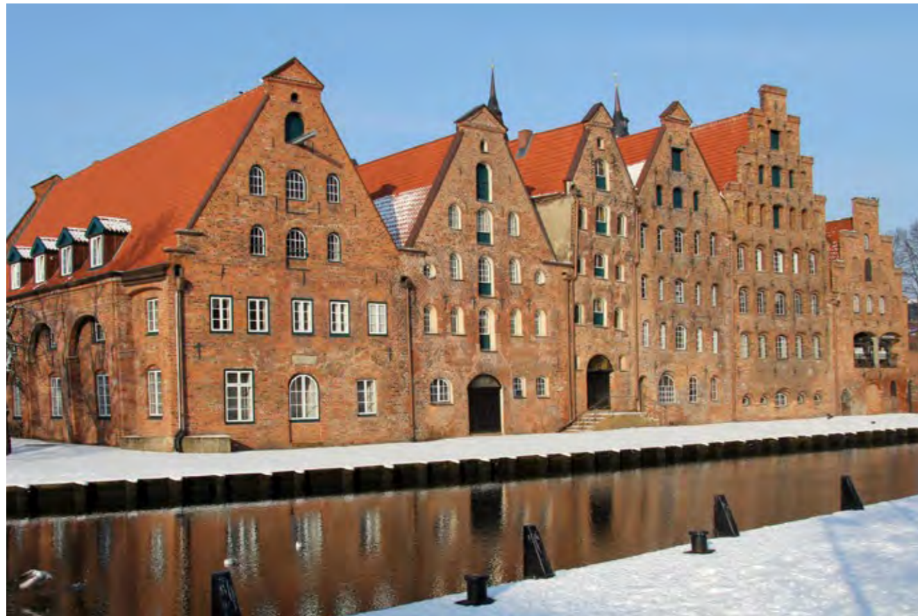
09.14 Salzspeicher- gruppe, Traveseite
