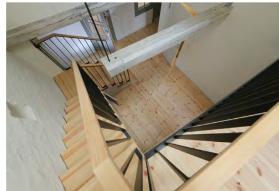
07.28 Treppe der Maisonettwohnung im 1./2. OG
