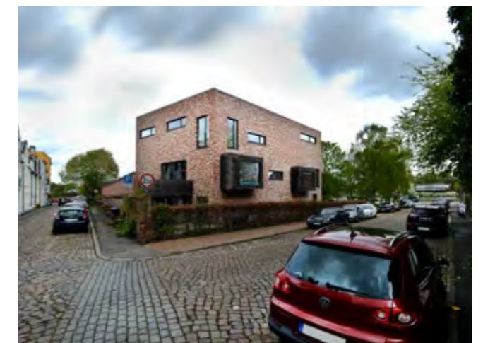
07.52 Weiter Lohberg / Ecke Wakenitzmuer mit Neubau Kita, 2020
