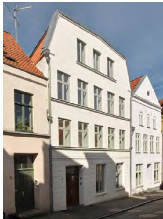
07.344 Straßenansicht nach der Sanierung
