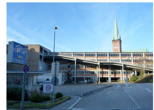
07.208 Städtebaulicher Missstand in der Marlesgrube: das Parkhaus Mitte
