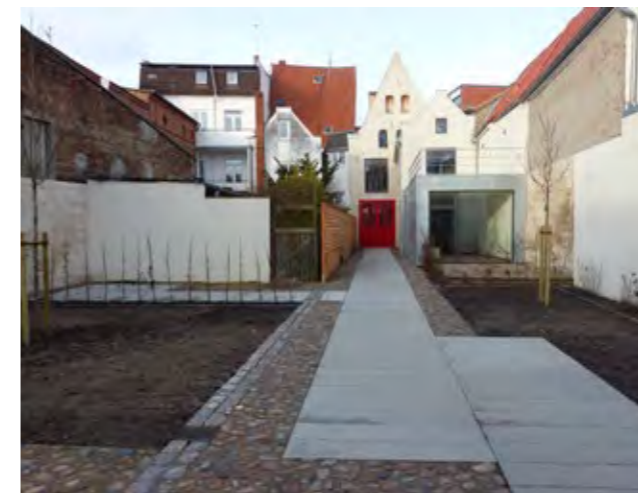
07.196 Freifläche nach Abbruch der Hofgebäude
