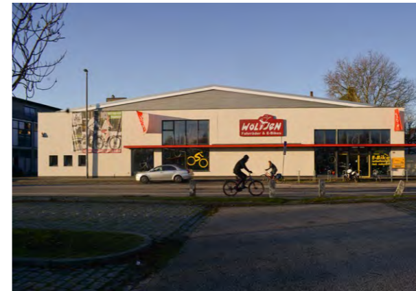
07.56 Kanalstraße 54-56 nach dem Umbau
