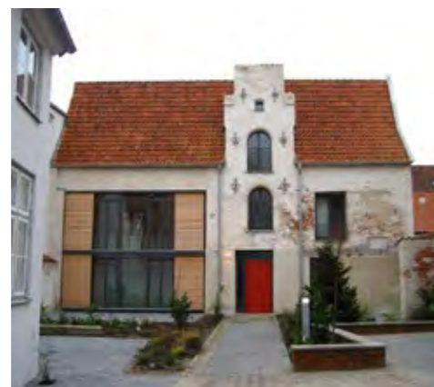
07.274 An der Untertrave 60, Saniertes Querhaus
