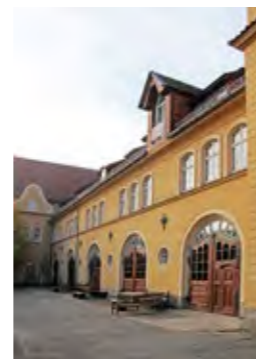
07.165 Rückseite der ehem. Wagenhalle
