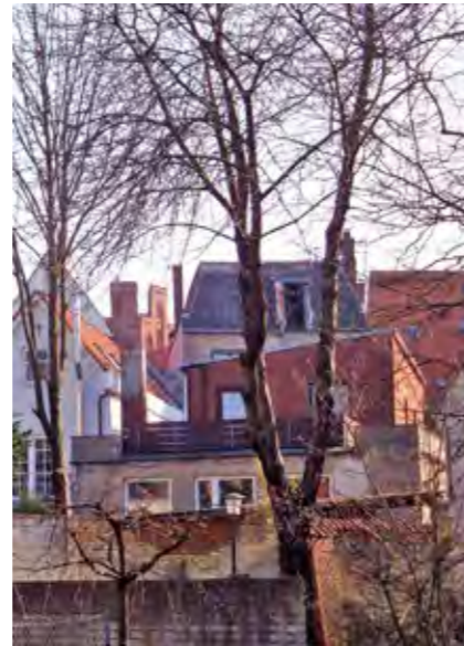
07.343 Ehemalige Hofsituation mit Anbauten
