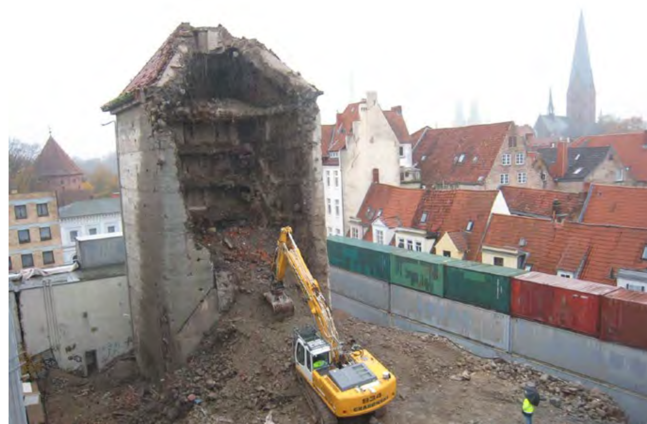
11.1 Abbruch des Aalhofbunkers 2010
