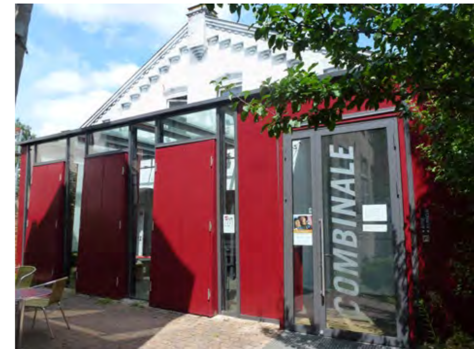
07.168 Eingangsbereich Theater Combinale
