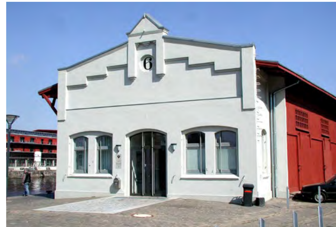
07.293 Kopfbau des sanierten Schuppen 6
