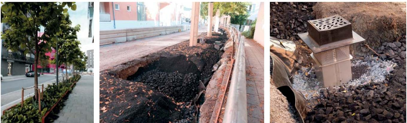
Abb. 17: Gezielte Versickerung von Regenabflüssen in den Pflanzgruben der Straßenbäume in Stockholm. Wichtige Elemente sind dabei grob gebrochener Schotter mit Oberboden gemischt sowie ein Be- und Entlüftungsschacht, der ebenfalls zur Bewässerung dient.
