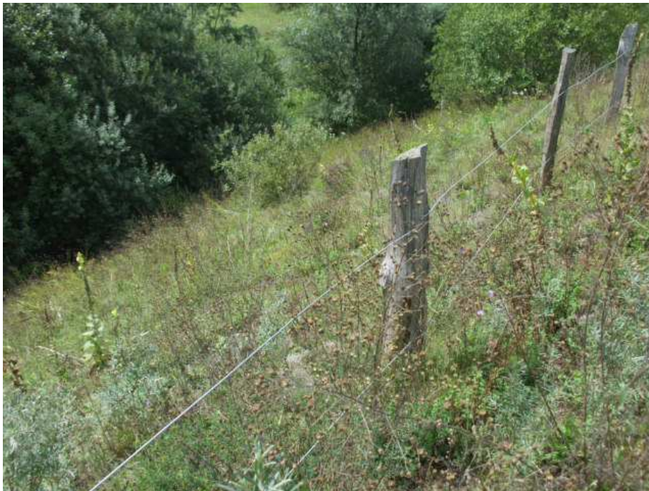
Südliche Böschung der Straße Bornkamp
