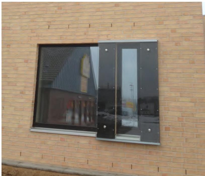
Abb. A 10.2: zwei seitlicher Absorber vor offenbarem Fenster in Kombination mit einem nicht offenbarem Fenster (aus schalltechnischer Untersuchung HUB 792.8432011 B aus 2011 Pflegeheim Travemünde Gnevendörfer Weg)
