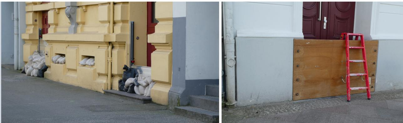
Abb. 21: Selbsthilfemaßnahmen bei Hochwasser an der Obertrave
