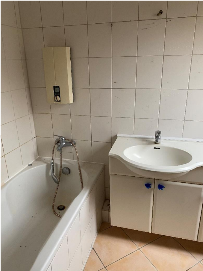
Hauseingang links, Bad im Obergeschoss
