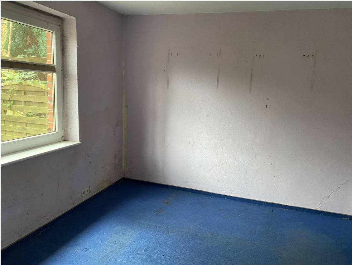
Hauseingang links, Zimmer im Erdgeschoss
