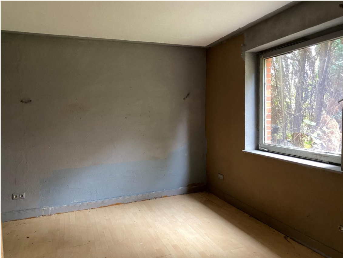
Hauseingang rechts, Zimmer im Erdgeschoss
