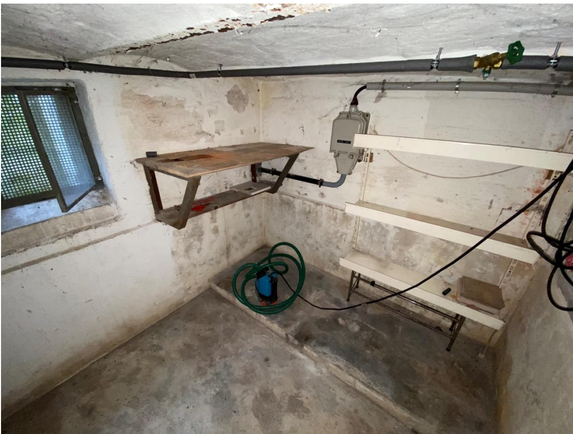
Hauseingang links, Keller
