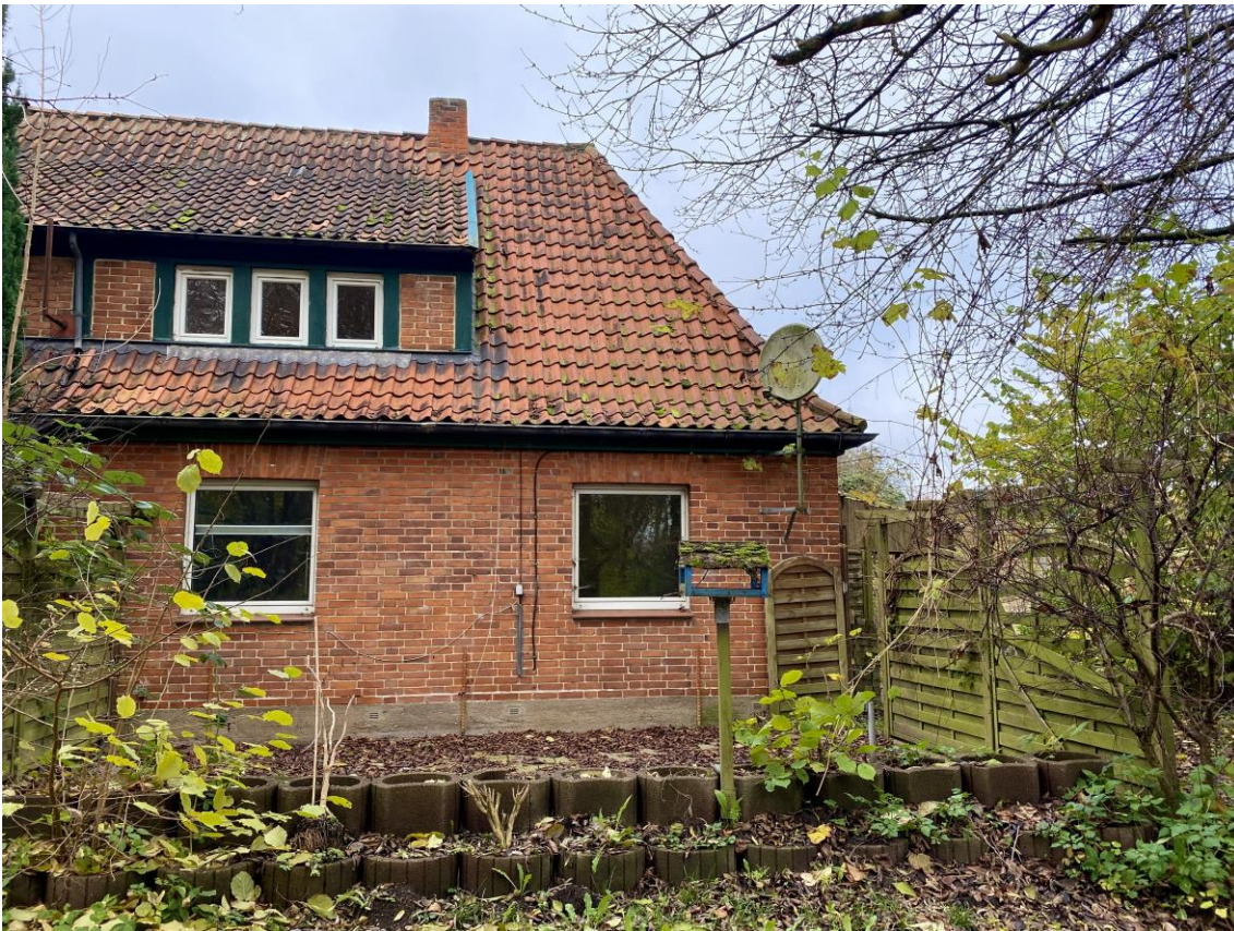
Ansicht linke Haushälfte, Terrasse
