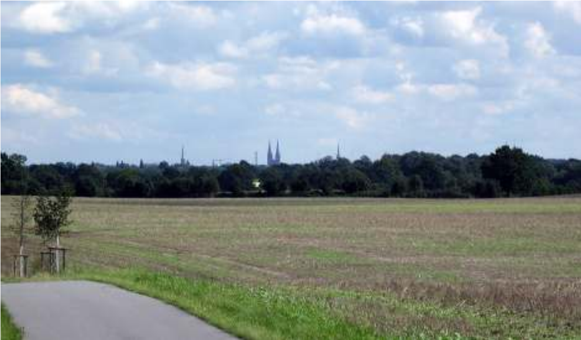
Prüfpunkt 22: K 78 westlich Dahmsdorf
