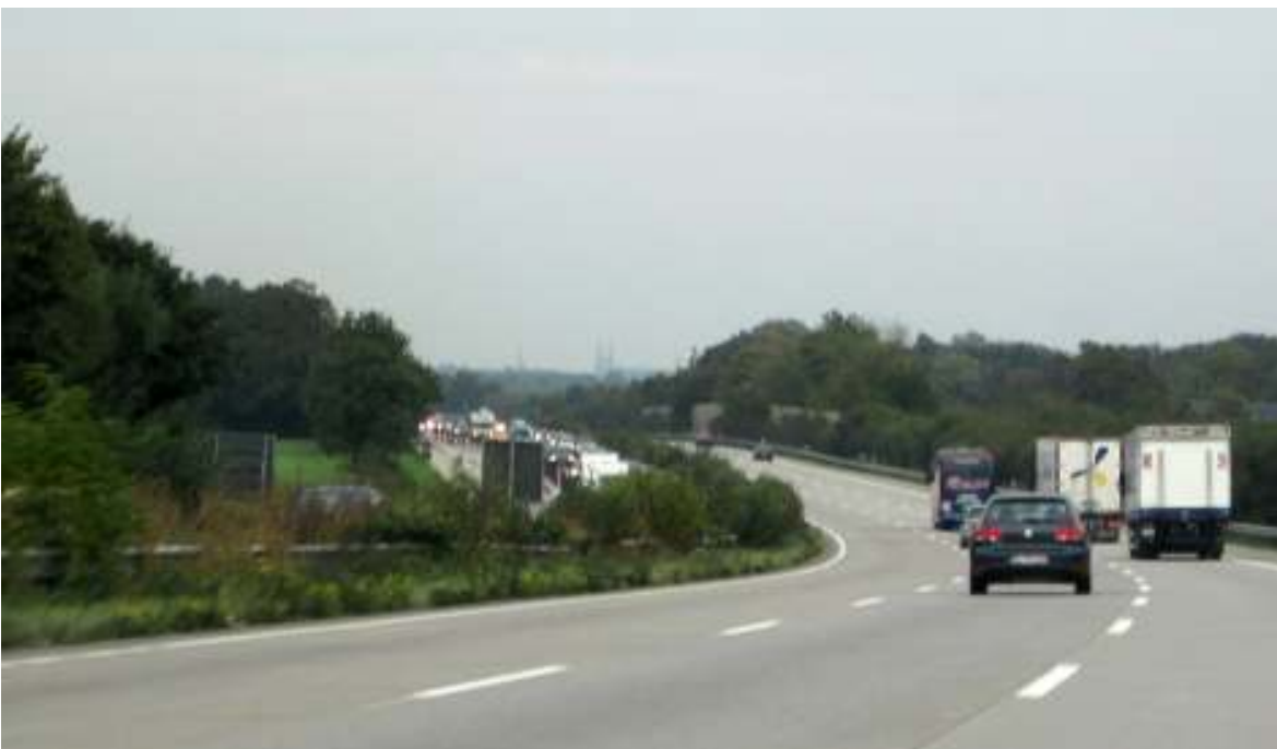
Prüfpunkt 19: A1 Ausfahrt Reinfeld Rcht. Norden
