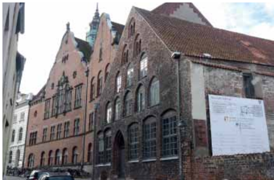
Sanierung des Kranenkonvents aus Mitteln des Investitionsprogramms Nationale Welterbestätten des Bundes, Hansestadt Lübeck Foto: Hansestadt Lübeck
