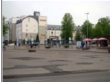
Sanierung von Gehwegen und Fahrbahnen
