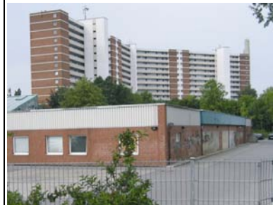
Sanierung von Wohnungen
