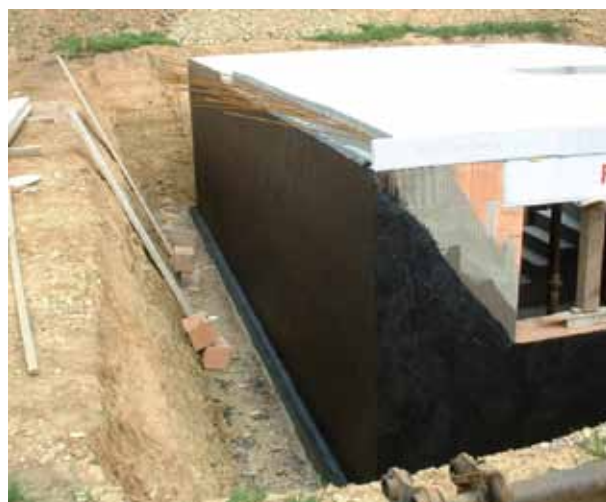
Foto: PCI Augsburg GmbH
