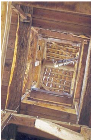
Engelsgrube 47. Windenschacht durch drei Böden. Ganz oben die Lastwelle (daneben eine anlässlich der Sanierung 1983 installierte elektrische Winde) Um 1600. Foto: Manfred Finke.
