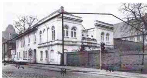
Vor dem Abbruch (eingezeichnet ist die ursprünglich geplante Baumasse)
